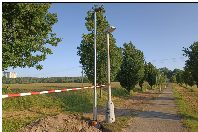
Rekonstrukce veřejného osvětlení II. etapa
