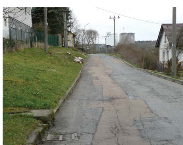
Ulice Ke Koupališti projde v letošním roce rekonstrukcí.
